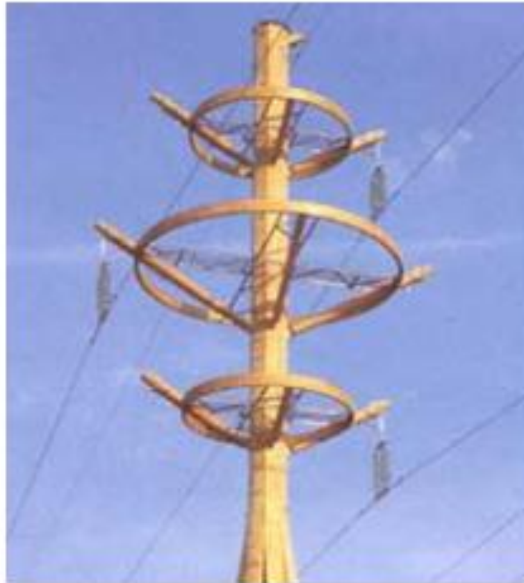
Pylône électrique en Pin lamellé-collé, Abergement-la-Ronce (France) Designer : Martin Szekely.
