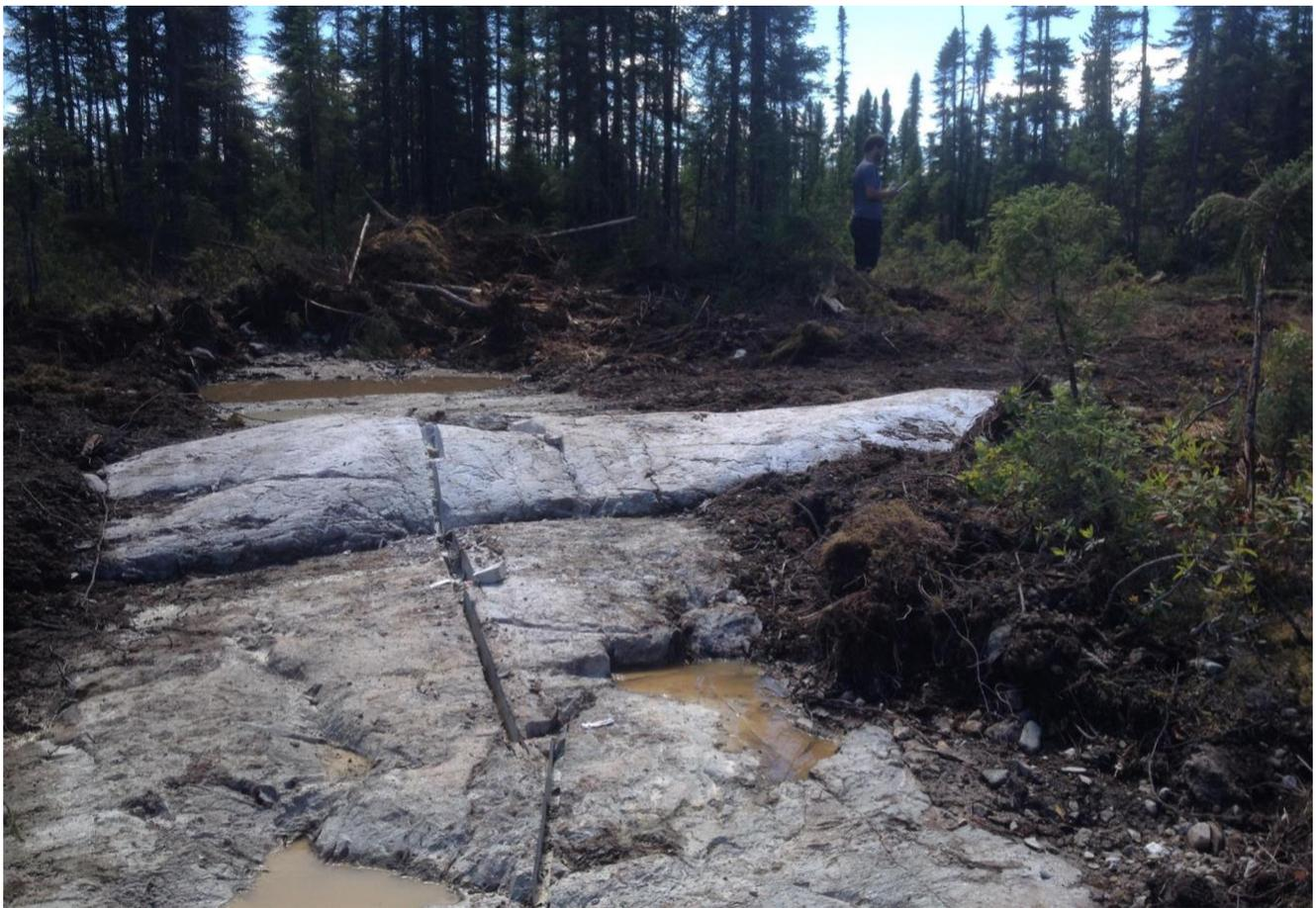
**Décapage à la pelle mécanique et échantillonnage sur des claims miniers (crédit E.C.B.)**
